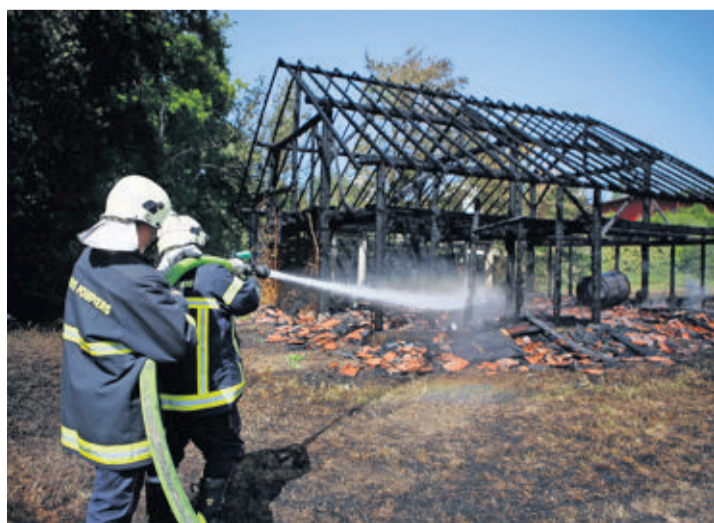
Les pompiers ont rapidement maîtrisé le feu. Après une demi-heure, il ne restait plus que la structure calcinée. PATRICK GILLIERON LOPRENO
